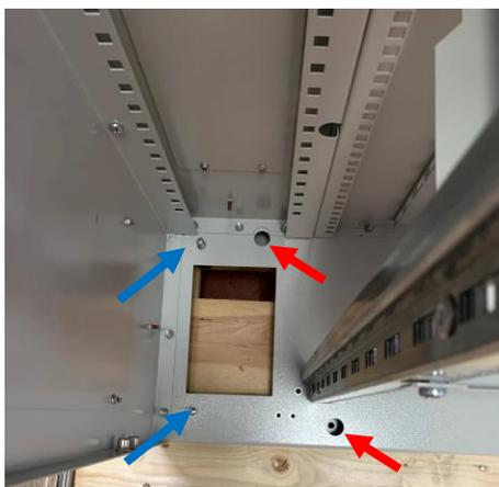
Piedini per la regolazione di livello dell'armadio lato sinistro (in BLU) e per fissaggio a pavimento (in ROSSO)
