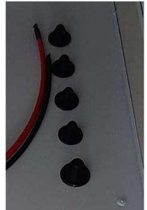
L'introduzione dei cavi avviene tagliando la piramide ad un diametro ridotto del 25% rispetto al cavo da inserire. Ogni anello riporta la misura del diametro corrispondente. Il passacavo così determinato garantisce una protezione IP66.
